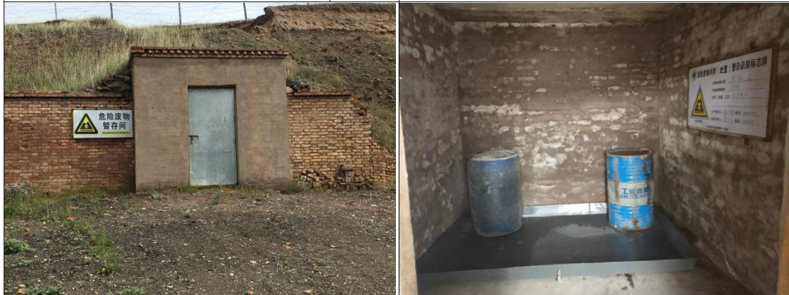
危险废物暂存间
