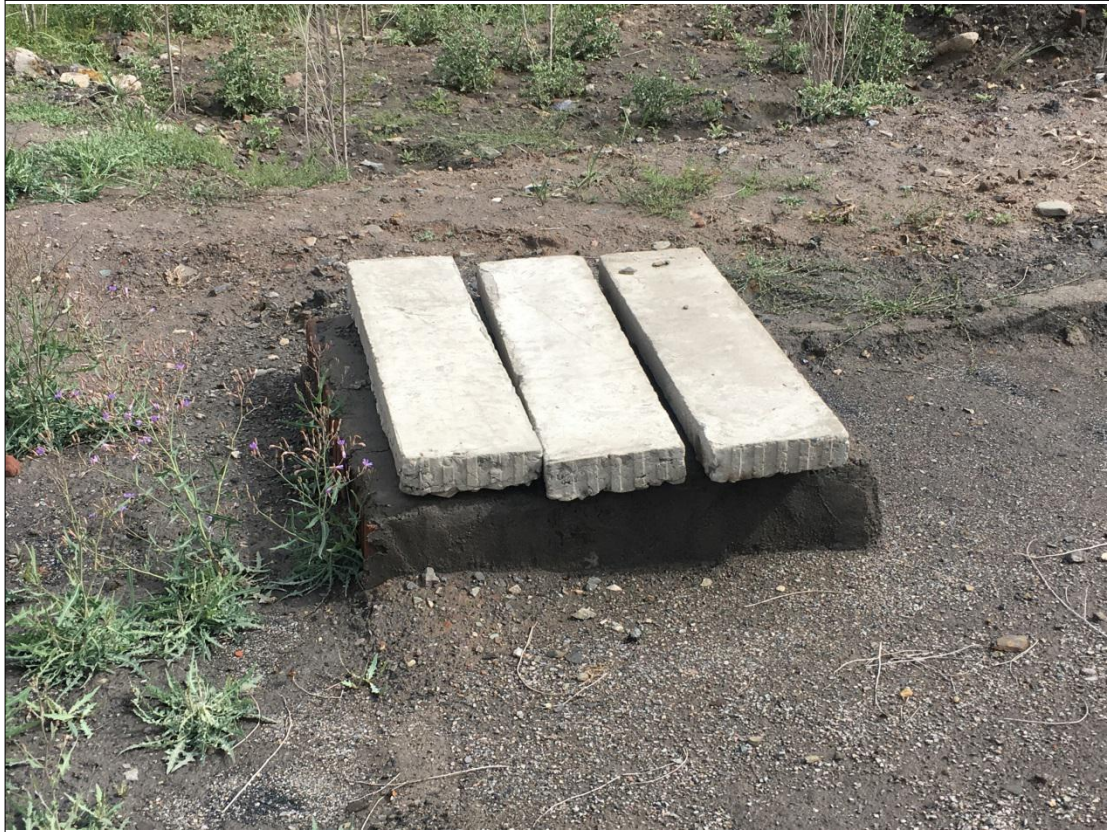
初期雨水收集池
